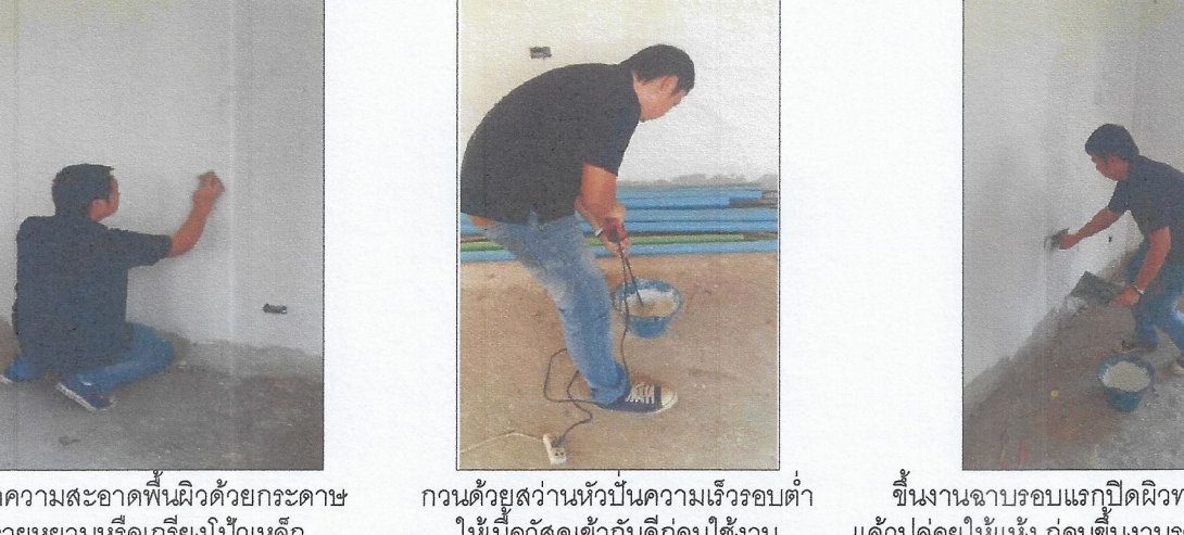
ทำความสะอาดพื้นผิวด้วยกระดาษทรายหยาบหรือเครื่องโป้วเหล็ก ควรทำความสะอาดพื้นผิวเดิมก่อนฉาบปูน ซึ่งงานฉาบปูนแรกเปิดผิวด้วยน้ำสะอาดก่อนจะฉาบ
